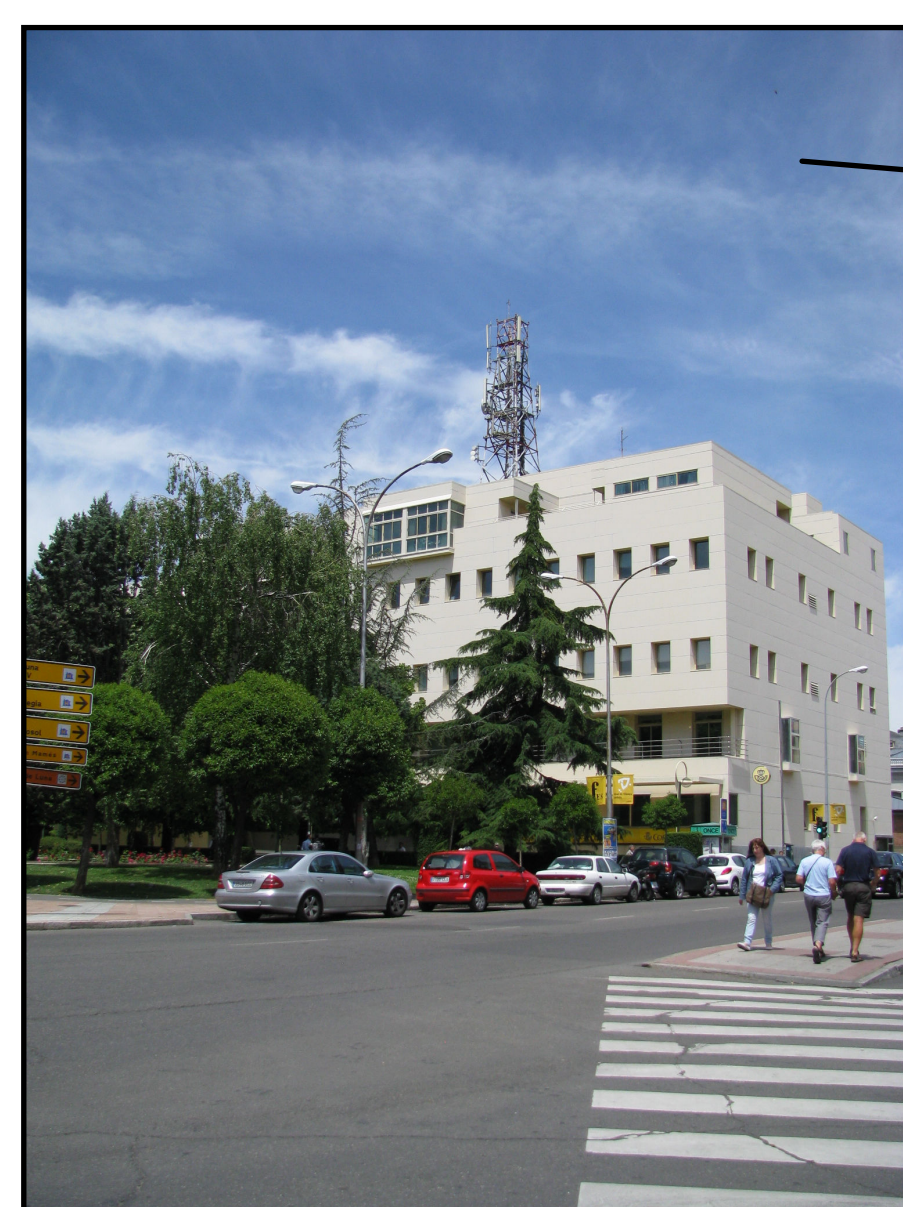
Avda. Independencia - Edificio Correos
